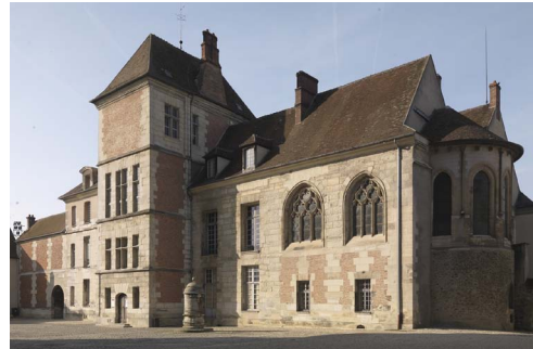
Guillaume Briçonnet mena d'importants travaux sur sa résidence épiscopale ; on lui attribue notamment la construction du grand escalier en brique et pierre qui domine la façade.
