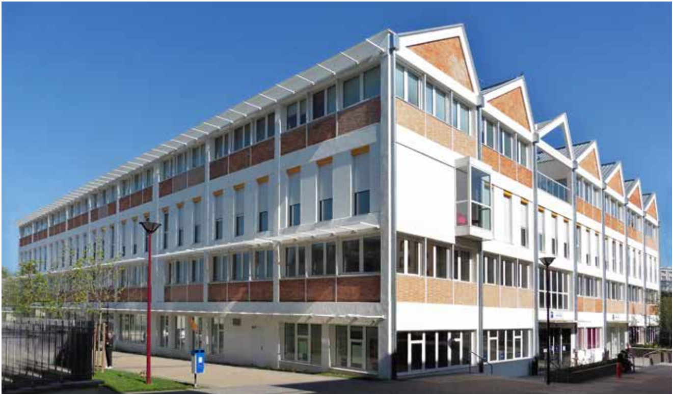
14. ZAC de l'Aérospatiale à Châtillon (Hauts-de-Seine) : l'atelier d'assemblage des missiles reconverti en centre de soins. Châtillon (Hauts-de-Seine), Urban Development Zone Aérospatiale. Missile assembly plant converted into a care centre.
