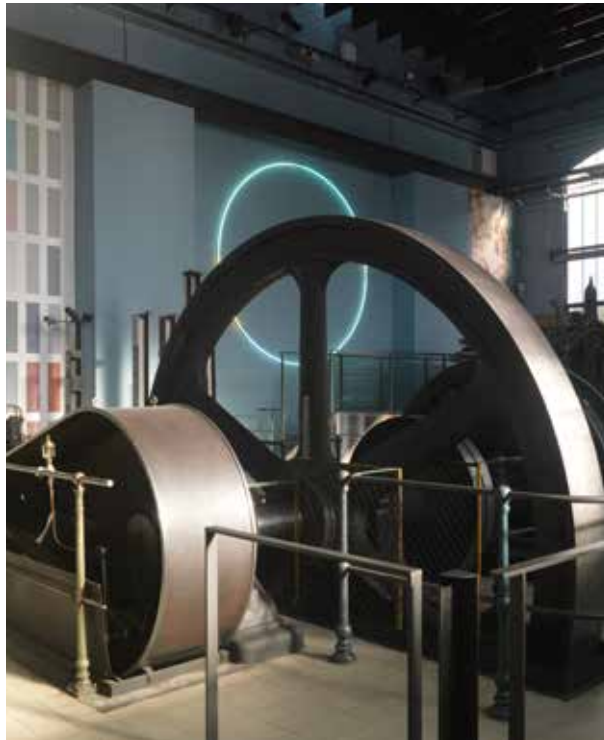
4. La centrale électrique de l'ancienne manufacture de papiers peints Leroy, Espace culturel « Les 26 Couleurs ». Saint-Fargeau-Ponthierry (Seine-et-Marne), power station of the old Leroy wallpaper manufacture, "Remembrance place" and cultural space « Les 26 Couleurs ».
