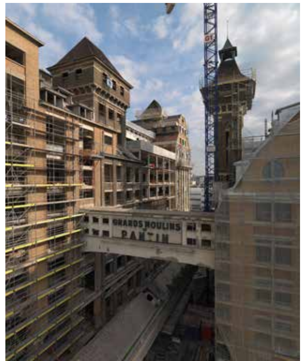
3. Les travaux de reconversion des Grands Moulins de Pantin (Seine-Saint-Denis).
