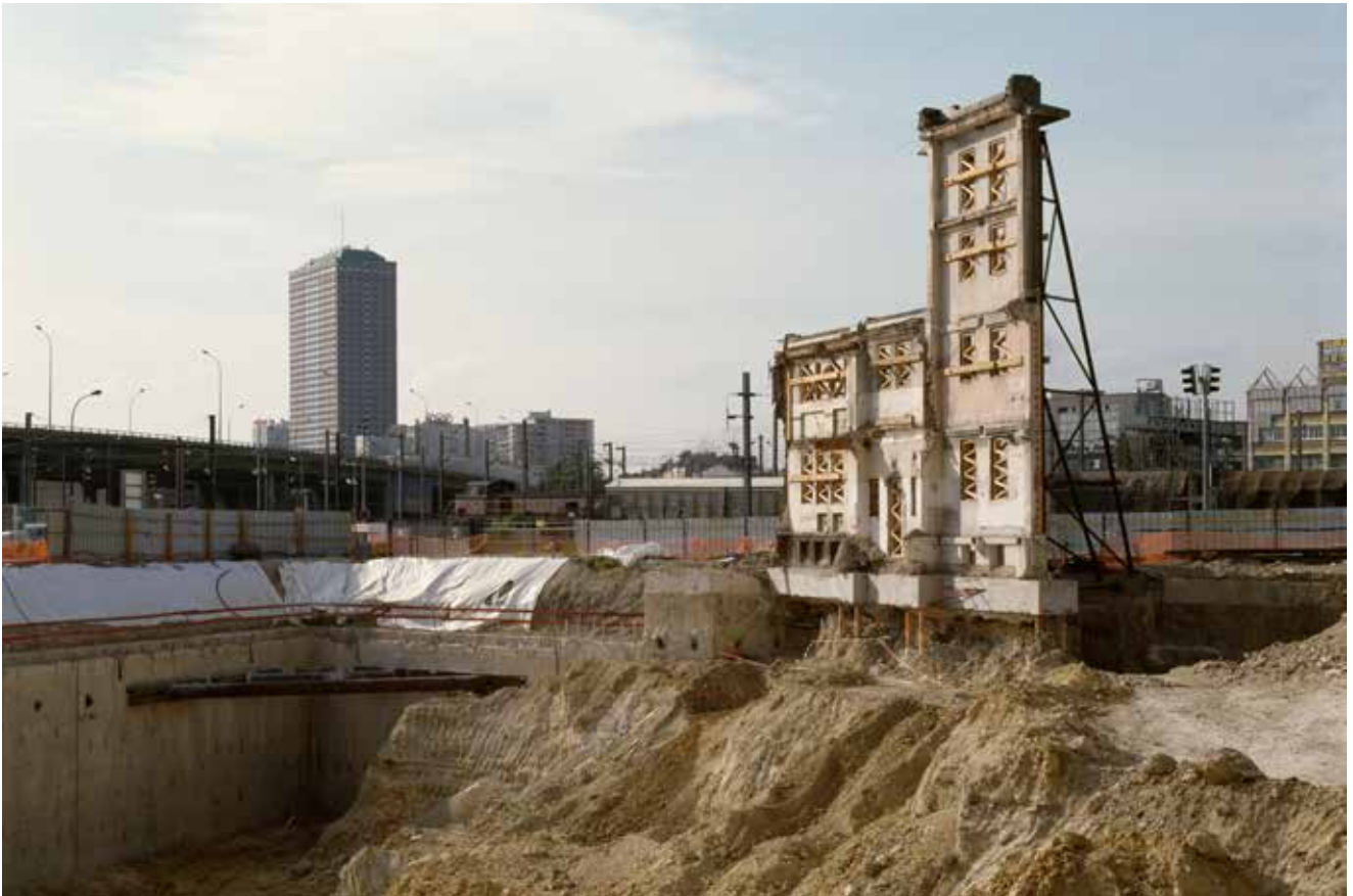
11. La façade de la « Boulangerie » des Grands Moulins de Pantin, soutenue par des micro-pieux à Pantin (Seine-Saint-Denis) en 2007. Pantin (Seine-Saint-Denis), façade of the "Bakery" supported by micro-stakes, 2007.
