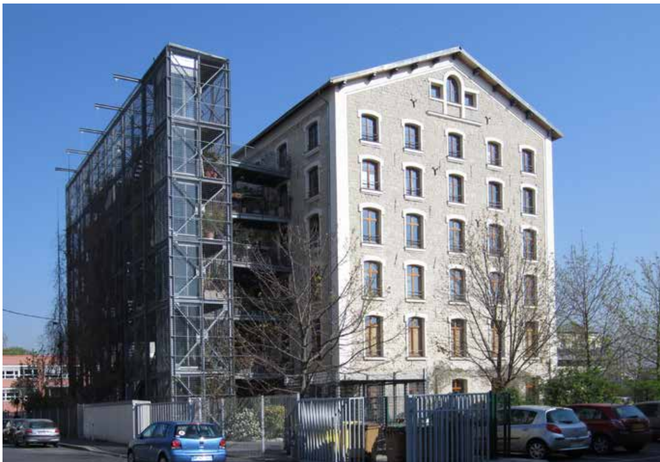
8. L'ancienne usine de pâtes alimentaires Groult reconverte en ateliers-logements à Vitry-sur-Seine (Val-de-Marne). Vitry-sur-Seine (Val-de-Marne), old Groult pasta factory converted into studio-dwellings.
