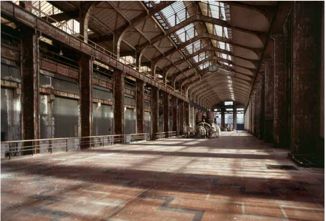
15. La salle des machines de la centrale thermique Saint-Denis 2, à Saint-Denis (Seine-Saint-Denis), avant sa reconversion en « Nef » (espace d'exposition) de la Cité du cinéma.
