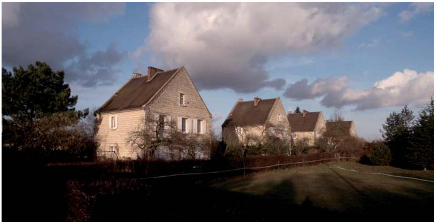
Pavillons de la cité ferroviaire d'Archères (Yvelines) © Inventaire général, ADAGP, 2005
