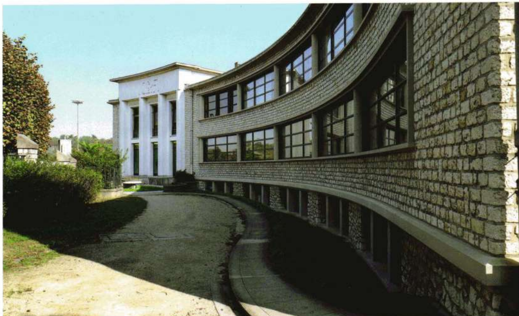
Entrée principale du siège social de la Coopération pharmaceutique française, place Lucien-Auvert. Ordre colossal en béton armé couvert de plaques de marbre.
