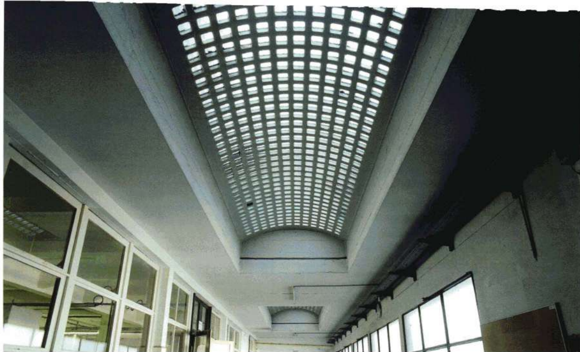
Intérieur du bâtiment de conditionnement. Lanterneau en béton translucide.
