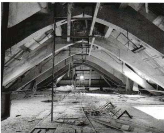
Charpente en béton armé du bâtiment des machines, 2001. Les combles abritaient l'installation pneumatique.
