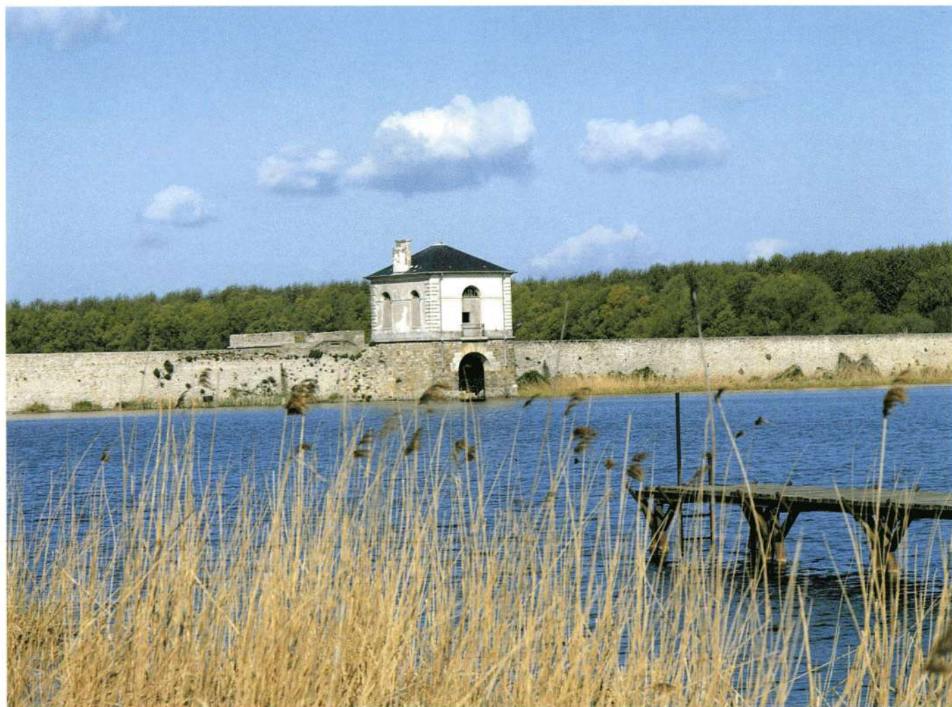
La digue d'aval de l'étang de Saclay comporte encore une vanne surmontée d'un petit édifice quelque peu dénaturé destiné à abriter les éléments de commande du mécanisme.
