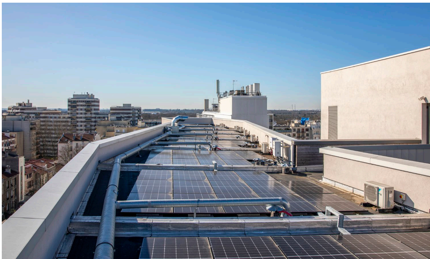
Panneaux photovoltaïques sur la terrasse du lycée neuf à Vincennes (94)
