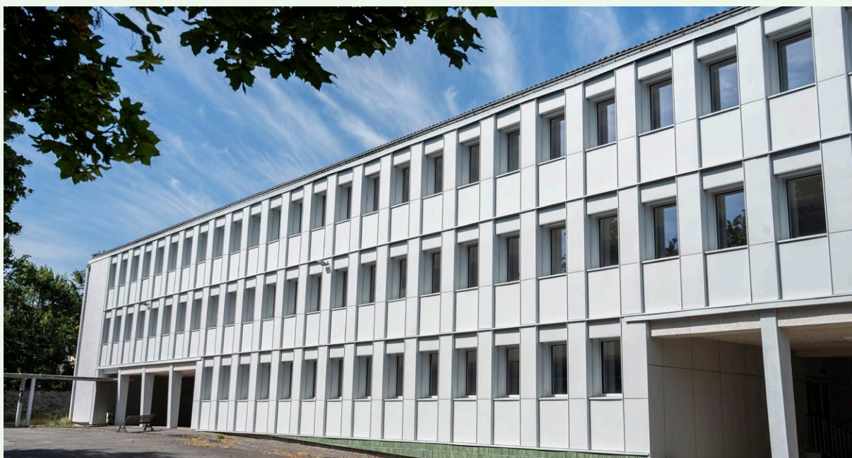
Une isolation complète avec une façade repensée et des menuiseries performantes
