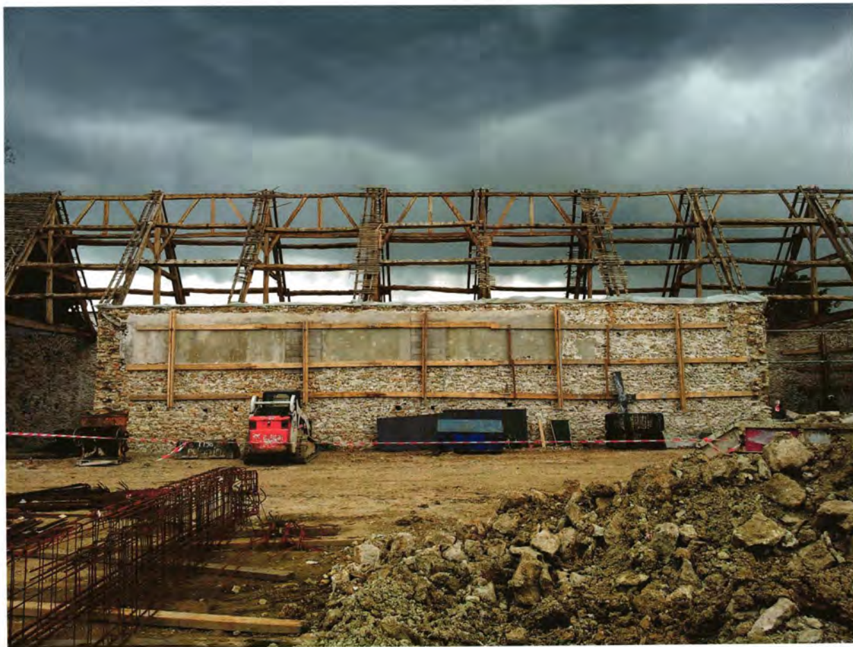
Des travaux lourds lors des reprises en sous-œuvre.
