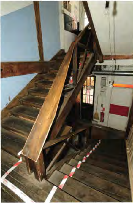
L'atelier de la rue Moreau (12 e arr.) : détail du garde-corps de l'escalier existant. Le dessin abaissé et élargi du garde-corps facilite le passage des pièces de bois de cette ancienne ébénisterie.
