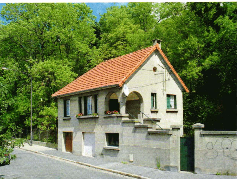
Parc des Beaumonts : maison du garde, rue des Charmes.
