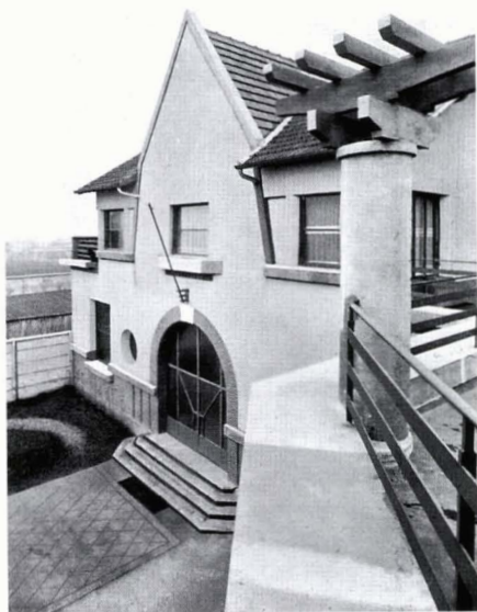
Groupe scolaire Anatole-France : façade de l'école maternelle, photographie vers 1935, F. Nanquette, op. cit.
