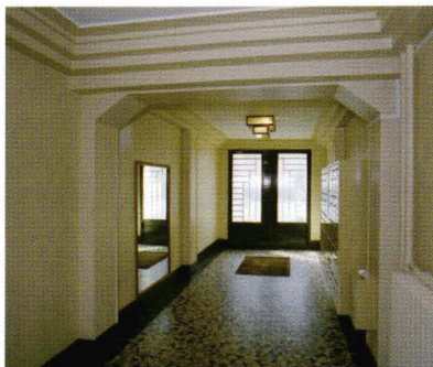
Immeuble du 59, rue de Vincennes : hall d'entrée et vitrail de la cage d'escalier.
