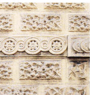
Maison du 87, avenue Pasteur et détail d'un mur au 87, rue Alexis-Lepère.
