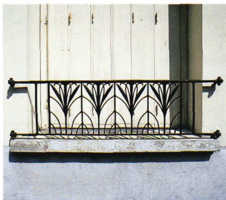
Garde-corps de l'immeuble du 16, rue Desgranges.
