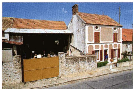
36, rue Pasteur. Le logis en léger retrait sur la rue est ici clairement séparé de la cour agricole.
