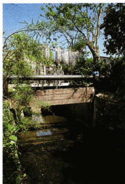
Planche servant de « vanne » pour faire remonter l'eau dans le lavoir.
