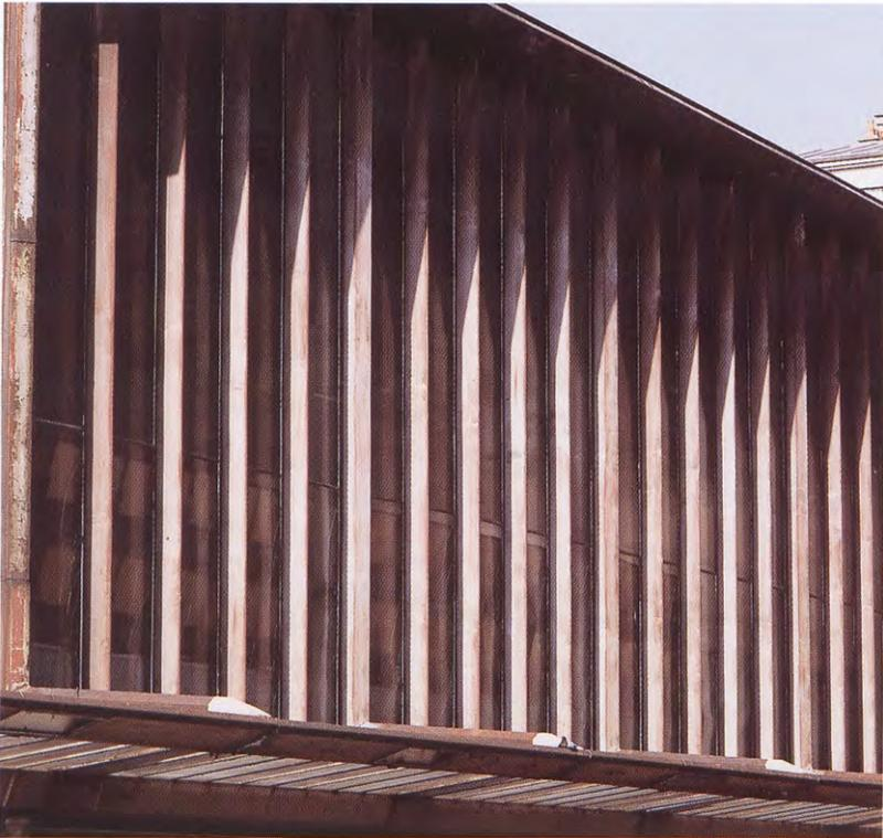
sanitaires préfabriqués et entièrement métalliques mis au point par Jean Prouvé. Les façades pleines, reprenant l'idée du mur-rideau expérimenté à Buc, sont constituées de deux panneaux préfabriqués comportant deux tôles séparées par un isolant et mises en tension par des ressorts.
