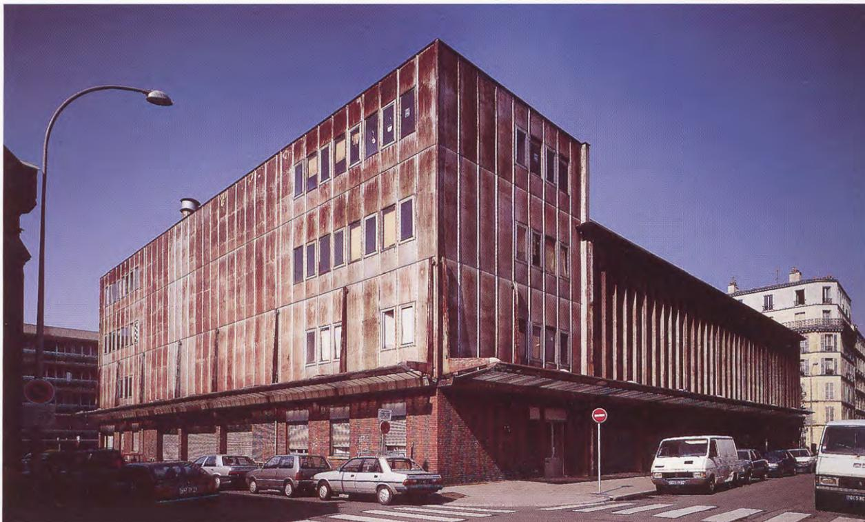
de mur-rideau, comme les planchers, plafonds et cloisons intérieures, avait montré combien ce système de construction facile à monter, à démonter et à transformer était souple. Grâce à l'expérience acquise, la Maison du Peuple va leur permettre d'innover dans l'art de bâtir en se fondant sur un programme nouveau.
