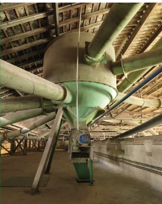
Ci-dessus : La Grande-Paroisse, silos à céréales de la coopérative UNCAC, aujourd'hui coopérative InVivo. Intérieur du silo n° 2. À gauche : conduits et silo de dépoussiérage. À droite : stockage.
