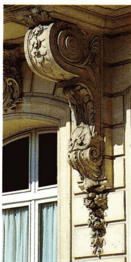
Console supportant le balcon, cour d'honneur.
