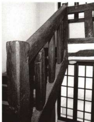
Escalier à deux noyaux et balustres carrés dans l'un des immeubles artisanaux.
