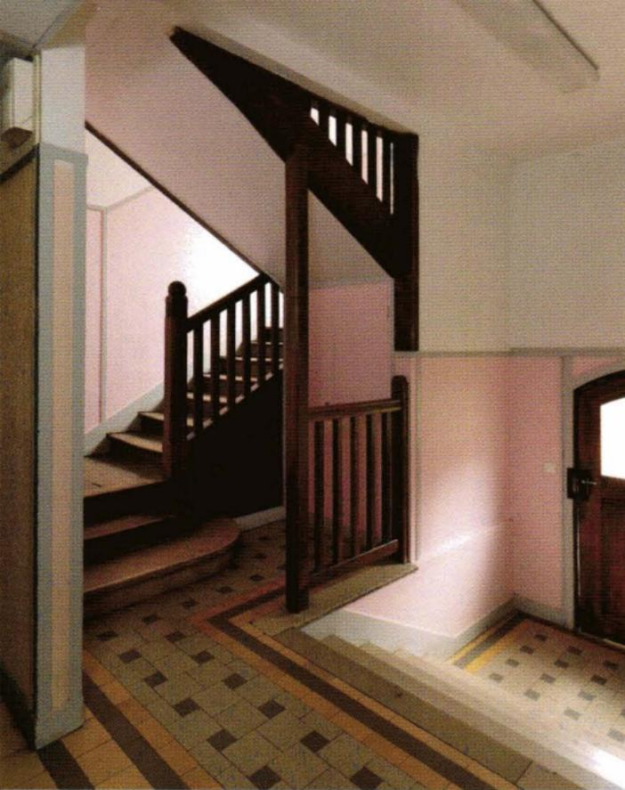
Escalier de distribution intérieure en charpente rampe sur rampe à deux volées.
