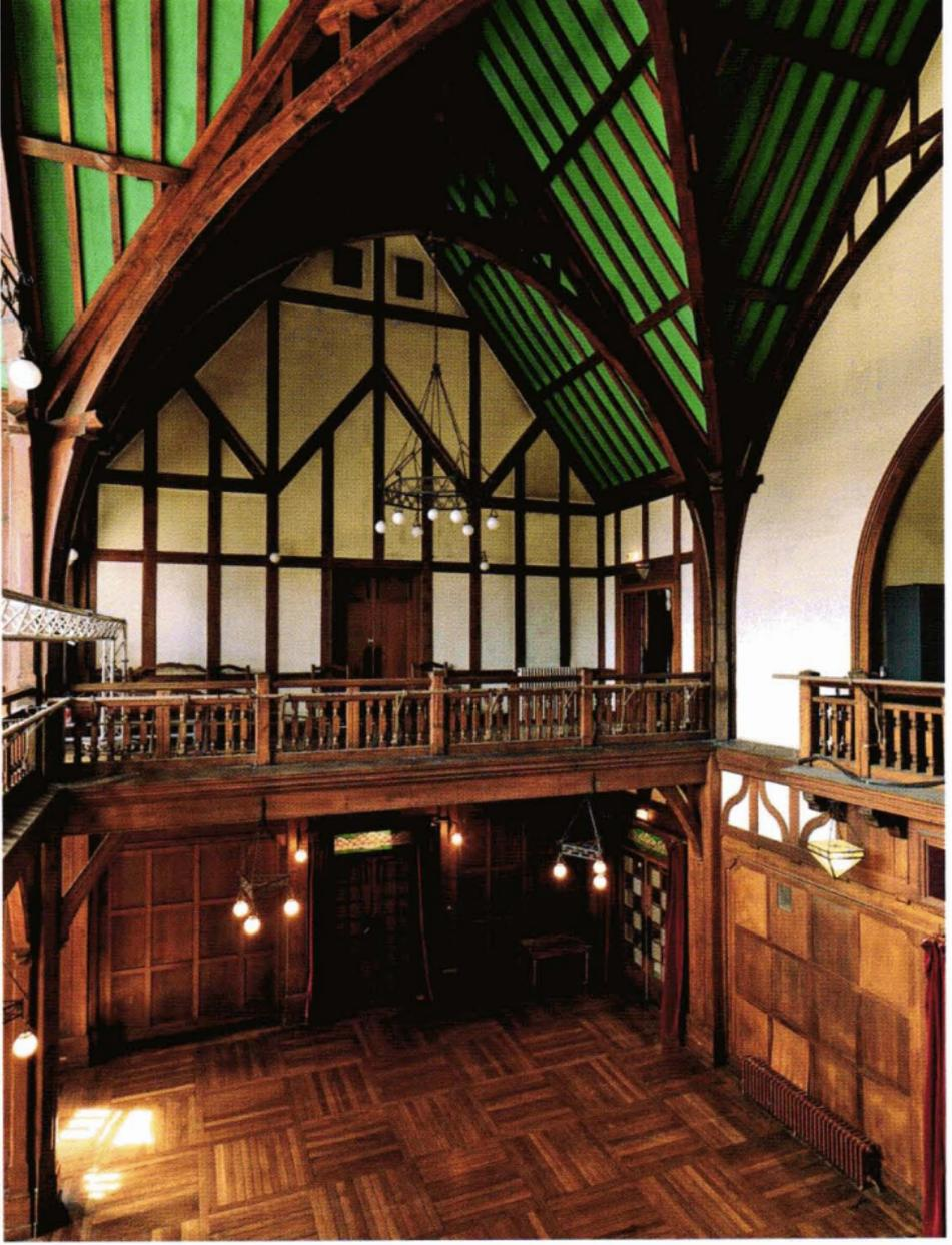
*Le grand hall, qui fait office de salle de fête, doit son volume impressionnant à une charpente montant de fond en comble. Il tire son élévation élancée d'une structure métallique habilement dissimulée par des poteaux de bois que prolonge une charpente aérienne.*
