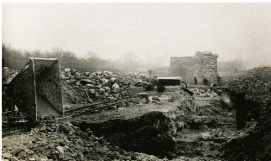
*Le bastion 82, en cours de dérasement (AN). Les moellons provenant de la démolition du bastion ont été utilisés pour la construction des murs des caves et sous-sols des pavillons de la fondation; une autre partie de ces matériaux a été affectée à la construction d'un groupe d'HBM du boulevard de l'Hôpital (13<sup>e</sup>).*
