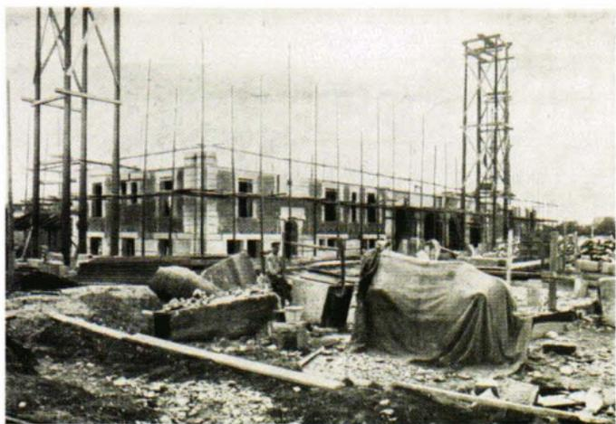
*Le pavillon Curie en cours de construction, 10 octobre 1923 (AN). Les bâtiments, construits en partie sur le fossé des anciennes fortifications, ont pour fondation des puits et poutres en béton armé réalisés par l'entreprise Sainrapt et Brice. Leur structure est en pans de fer avec remplissage de briques.*
