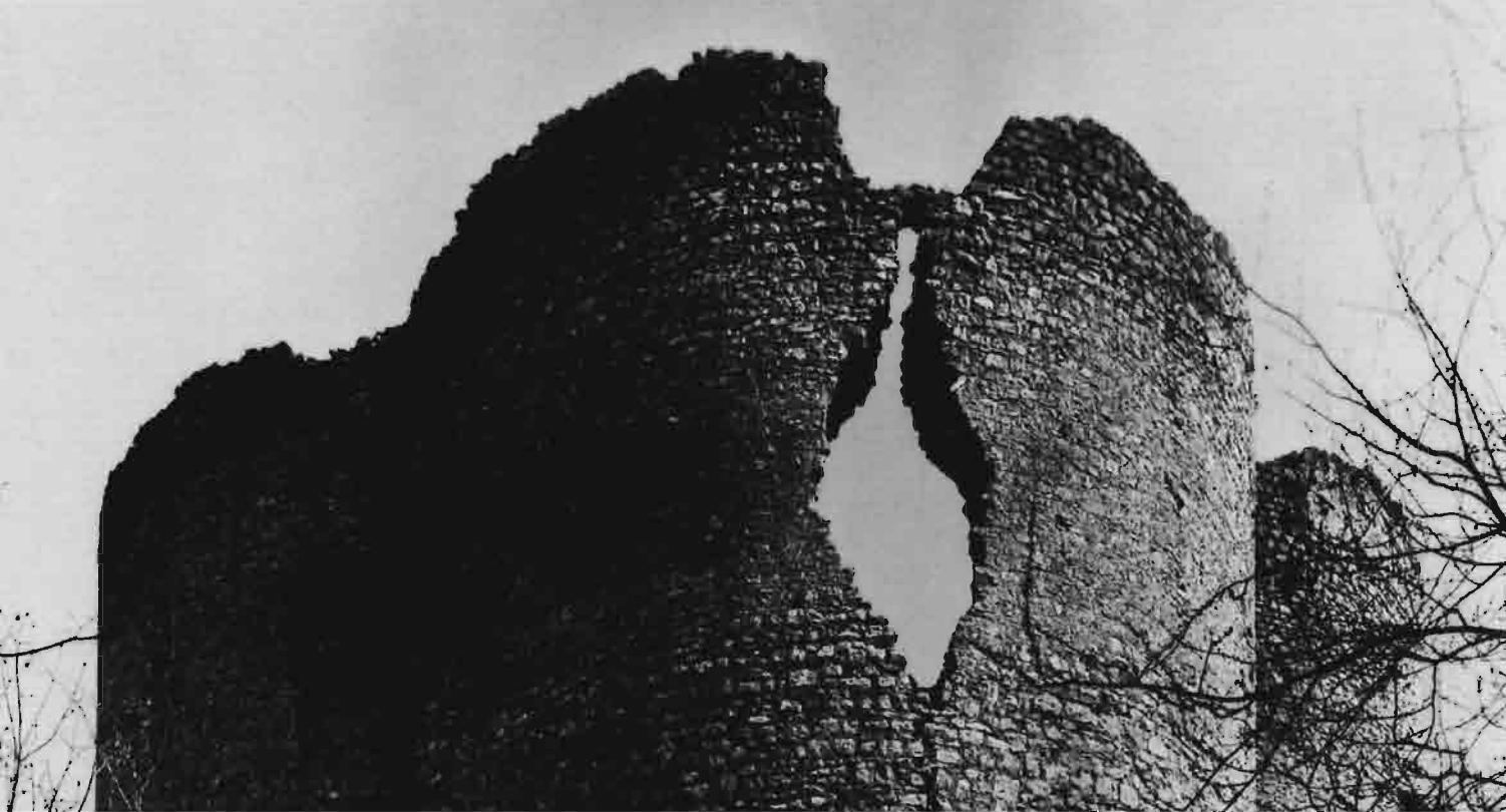
lin est profond d'une quarantaine de centimètres et n'est jamais visible en vis-à-vis sur le parement intérieur. L'échafaudage de la construction reposait donc à l'extérieur sur un poteau montant de fond contre lequel étaient ligaturées alternativement à gauche et à droite les pièces de bois introduites dans les boulins, de façon à assurer un meilleur contreventement.
