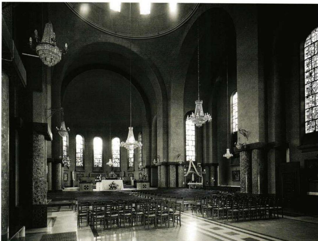
La structure en béton armé a permis à l'architecte de dégager un vaste espace intérieur propice aux grands rassemblements étudiants. Les colonnes jumelées aux fûts courts recouvertes, ainsi que leur soubassement, de plaques de marbre reconstitué supportent les hauts arcs en plein cintre recouverts, comme l'ensemble des murs, d'un crépi moucheté. Sous la nef et le chœur une grande salle sert pour les réunions.
