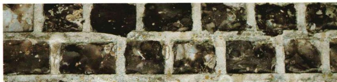
*Détail du mur de clôture sur le chemin de Prunay. L'appareil de moellons équarris de silex bruns, fréquent en Seine-Maritime, est une rareté en Ile-de-France.*
