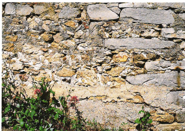
Longvilliers, ferme de la Bâte. Moellons de meulière et angle en grès.
