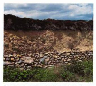
Un des rares murs de clôture en pierre et bauge, surmonté d'un chaperon de chaume, caractéristique de l'extrémité ouest du canton (ferme à La Boissière-École).
