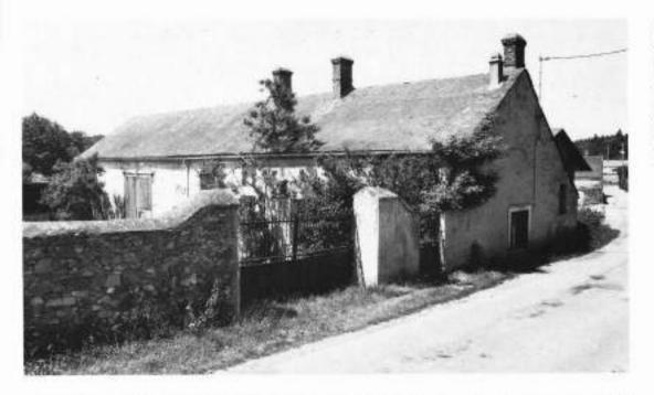
Maison de type bloc-à-terre aux Chaises. Perpendiculaire à la rue, ce bloc-à-terre en longueur abrite un logis côté rue et une grange sous le même toit, dont on aperçoit la grande porte. Le mur de clôture maçonné forme avec le pignon une unité de matière caractéristique de l'architecture vernaculaire.
