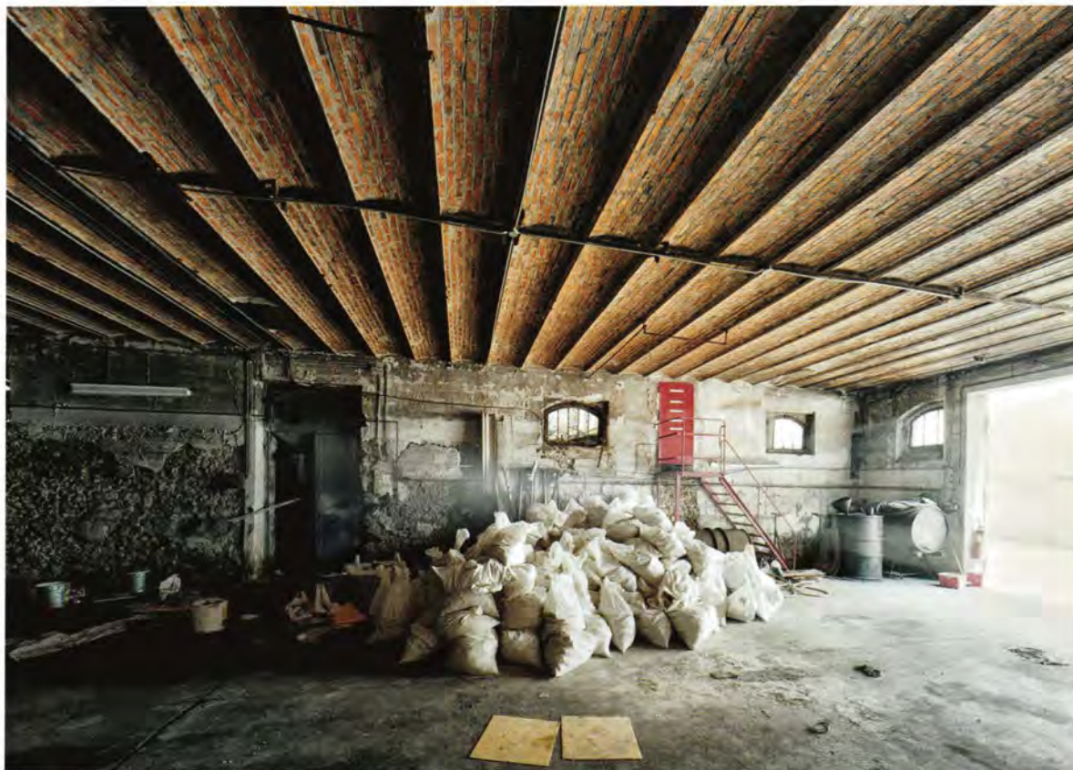
Pantin (Seine-Saint-Denis), plafond à voûtains de briques, distillerie Delizy-Doisteau, avenue Jean-Lolive (disparue).
