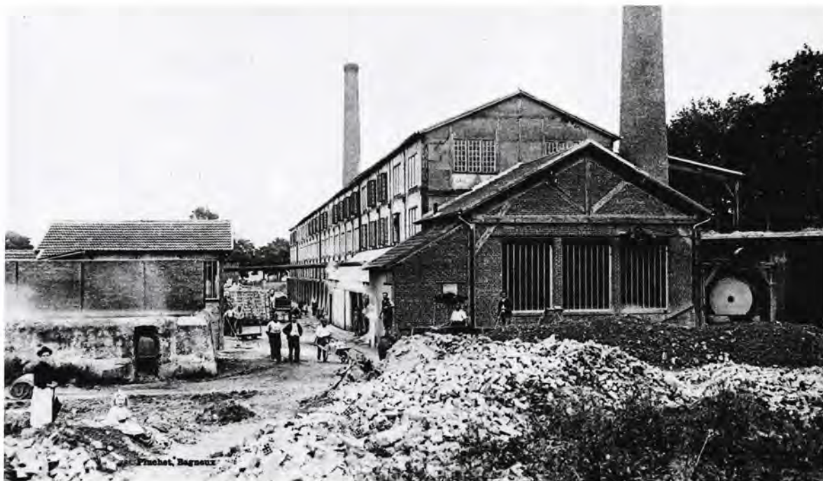
Bagneux (Hauts-de-Seine), vue d'ensemble de la briqueterie [disparue] avec l'atelier de broyage au premier plan et le four à l'arrière ; carte postale, début xx e siècle.
