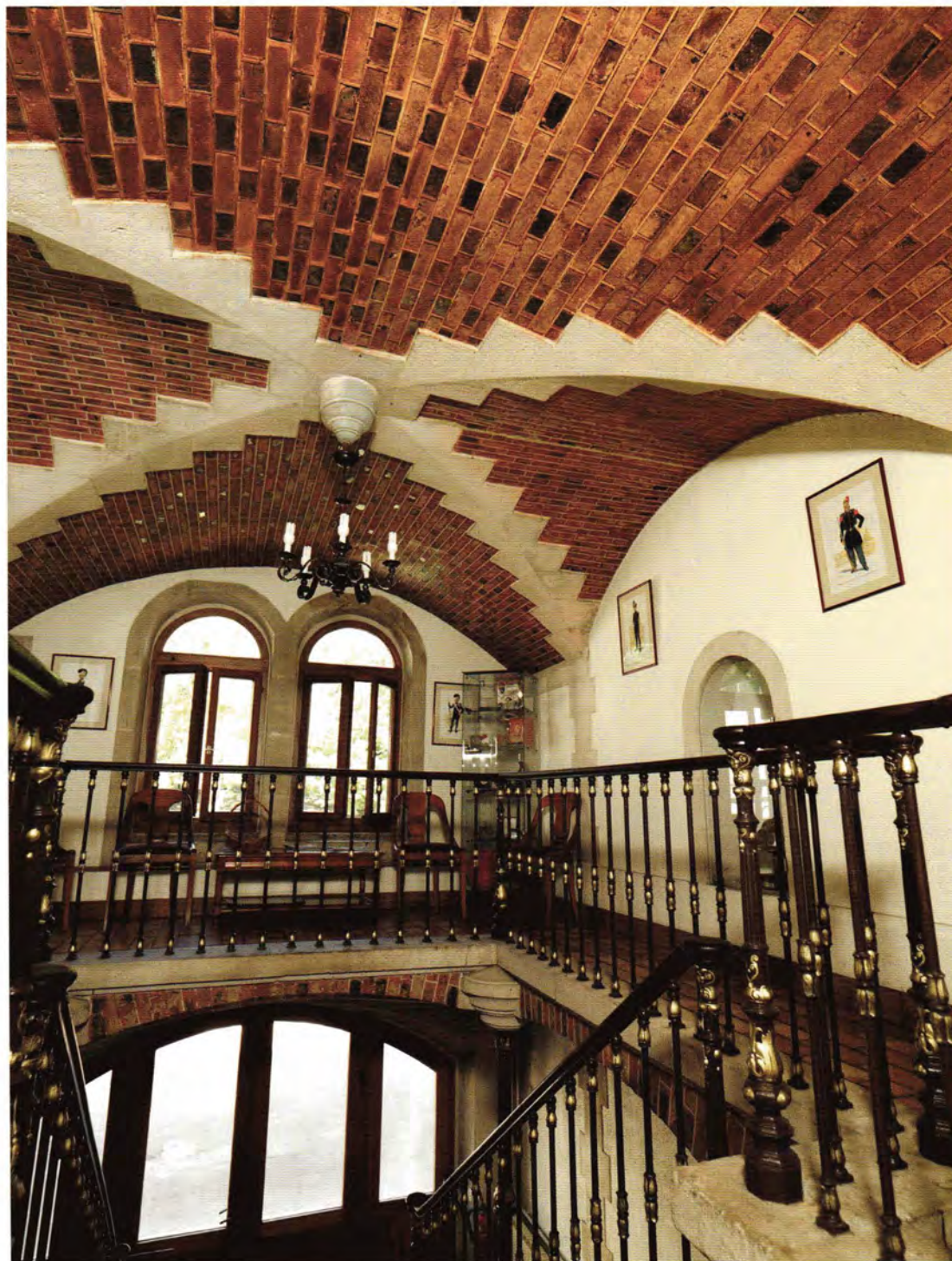
Villeneuve-Saint-Georges (Val-de-Marne), voûte d'arêtes plates à fourrure de brique à l'intérieur du fort.
