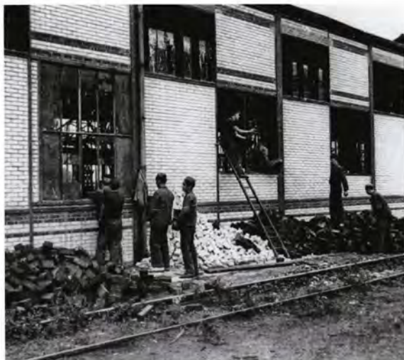
Nanterre (Hauts-de-Seine), ateliers ferroviaires de la Folie, remontage d'un mur de briques bicolores.
