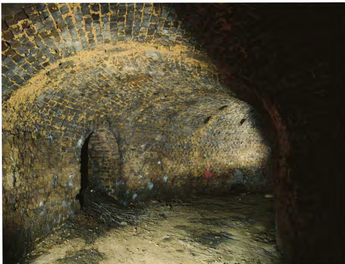
La Queue-en-Brie (Val-de-Marne), voûte tournante du four de la briqueterie (disparue).
