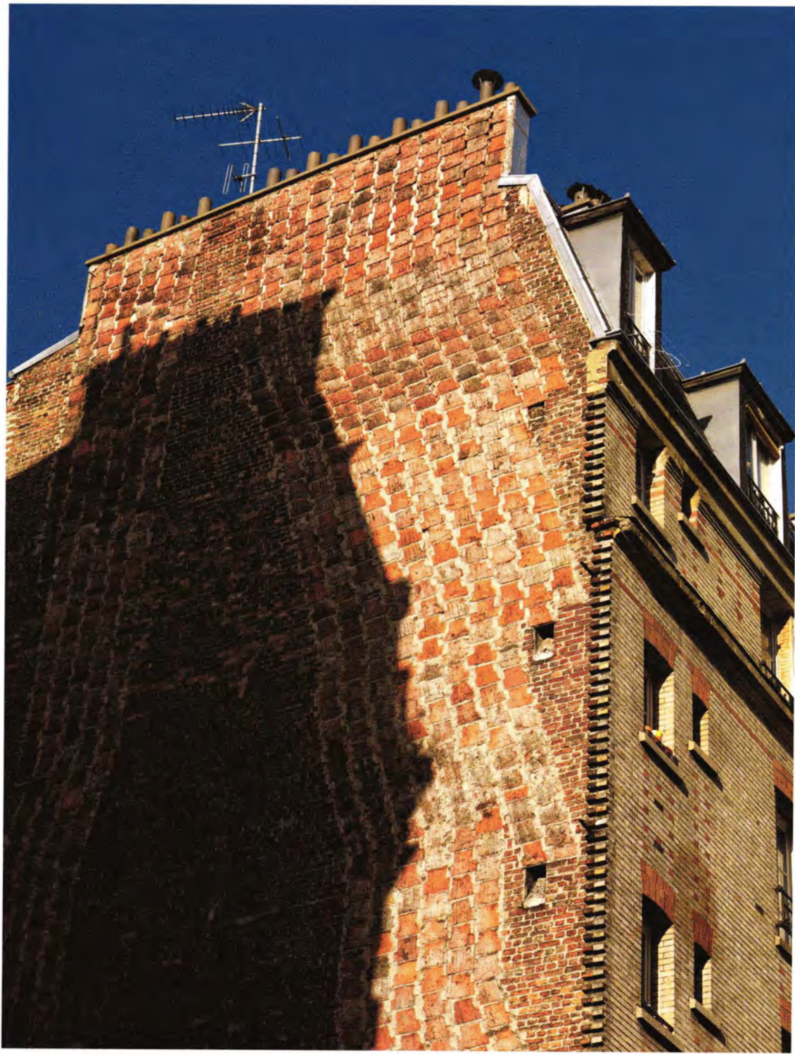
Pignon d'immeuble intégrant des conduits de fumée en wagons céramiques.
