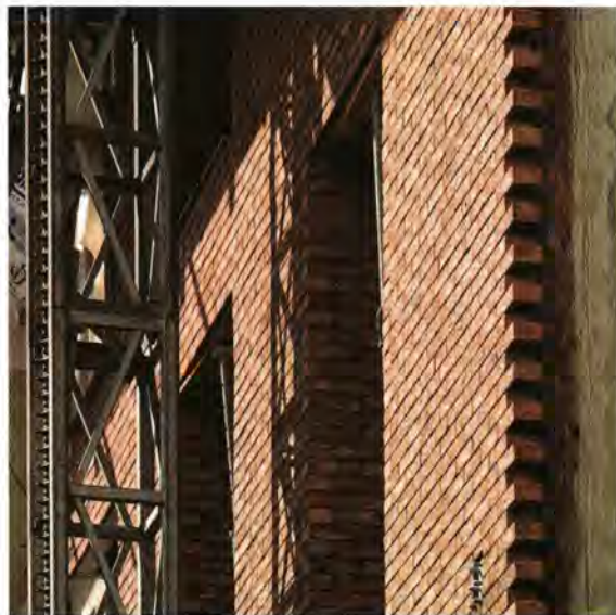
Paris (XIII e ), ZAC Massena, immeuble INALCO en construction en 2010 : montage d'un mur à double paroi dont une de brique, une autre de béton.
