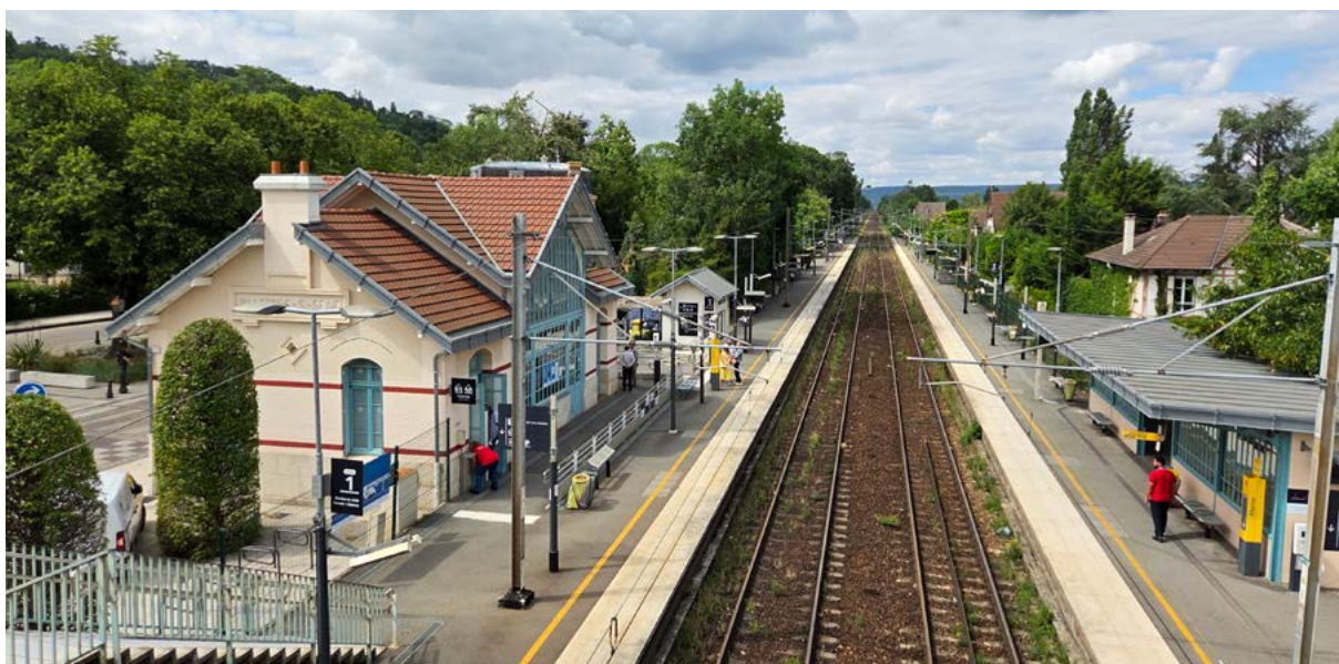
La gare de Villennes-sur-Seine (78).
