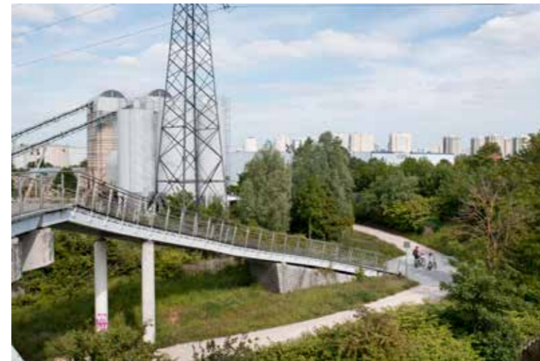
Légende : Nanterre, passerelle enjambant l'entrée du port industriel Crédit photo : © Ambroise Tézenas et Jémémie Léon. OPP de la vallée de la Seine francilien.
