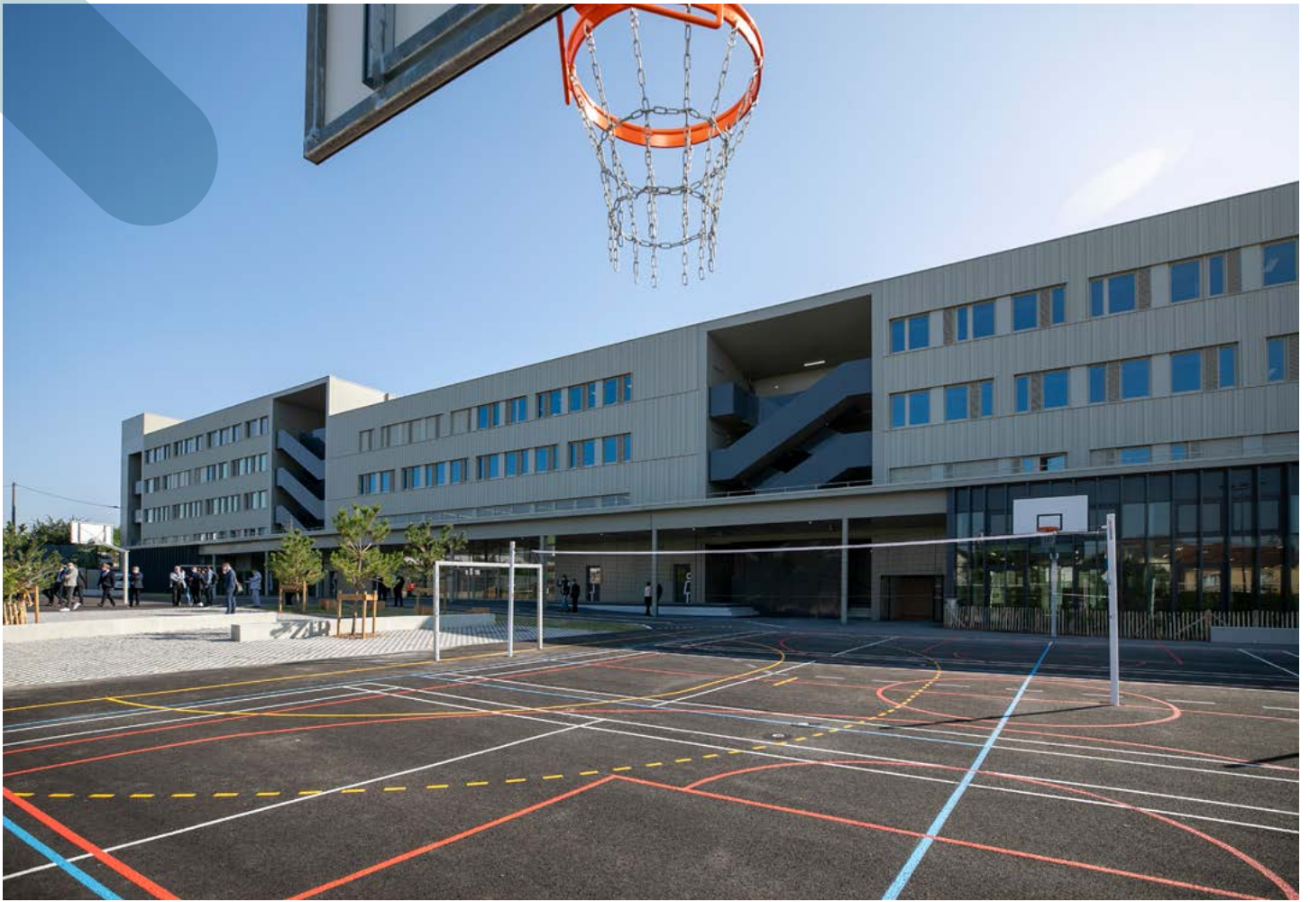
Lycée Joséphine-Baker - Pierrefitte-sur-Seine (93)
