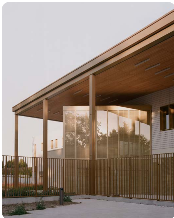
Lycée Voillaume à Aulnay-sous-Bois (93)
