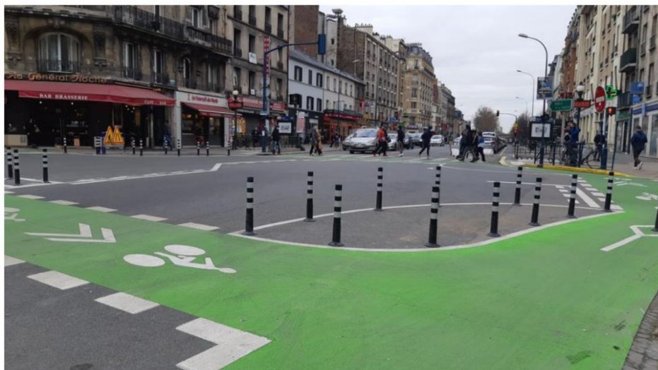
Figure 7 : Exemple d'aménagement d'un carrefour à îlots-amandes à Pantin (NB : le vert n'est pas réglementaire)
