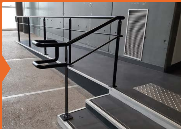
Création d'une rampe au lycée Evariste Galois à Noisy-le-Grand (93) .
