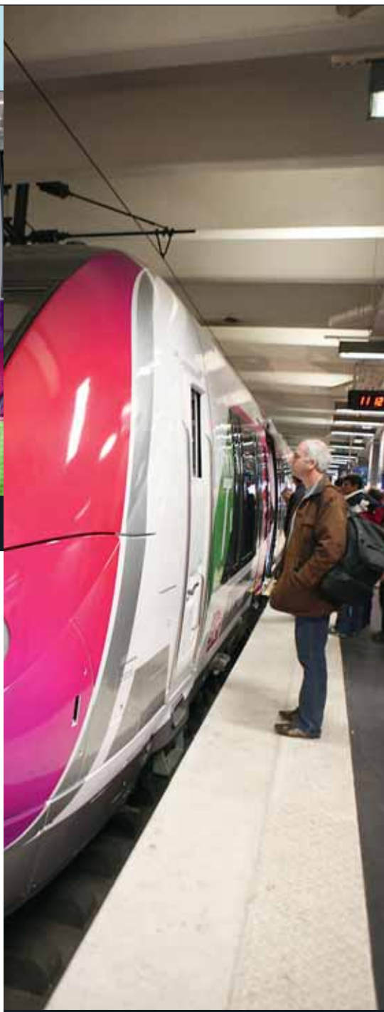
Les quais de la gare du Nord ont été rehaussés pour faciliter l'accès aux personnes handicapées.
