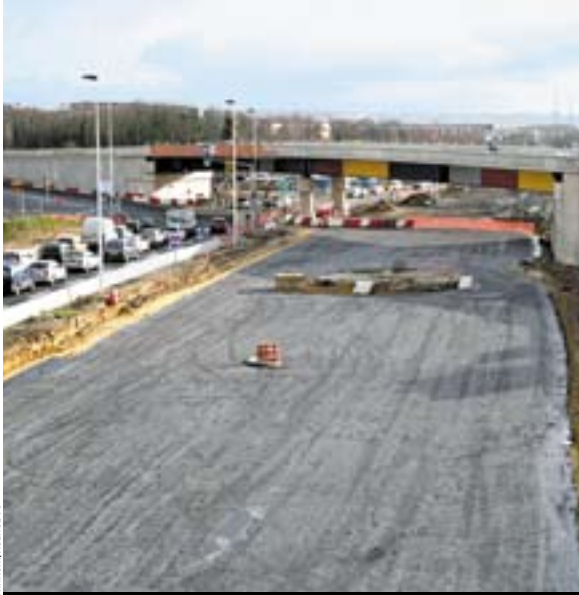
© ISABELLE ESPIR/AGENCE VII L'extension de la ligne 8 du métro à Créteil Sud est l'un des grands chantiers qui se poursuivra en 2009.
